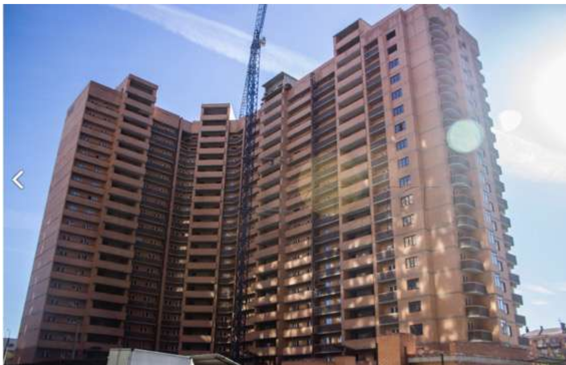
Рис.6.27. Этап строительства здания. Ноябрь 2017 г
