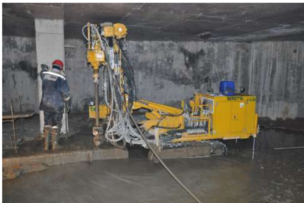
Рис.6.35. Выполнение грунтобетонной сваи
