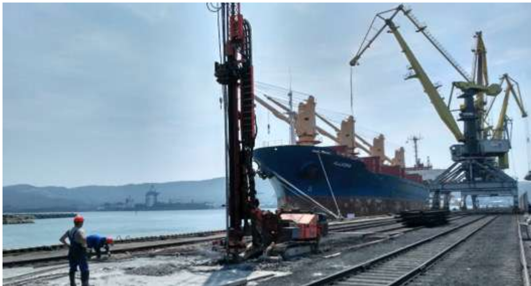
Рис.6.44. Реконструкция причала в порту Восточный, г. Находка
