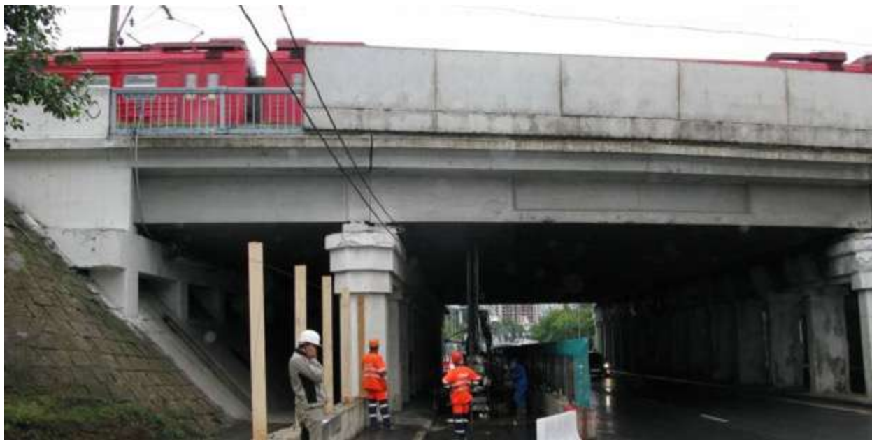
Рис.6.38. Общий вид площадки строительства
