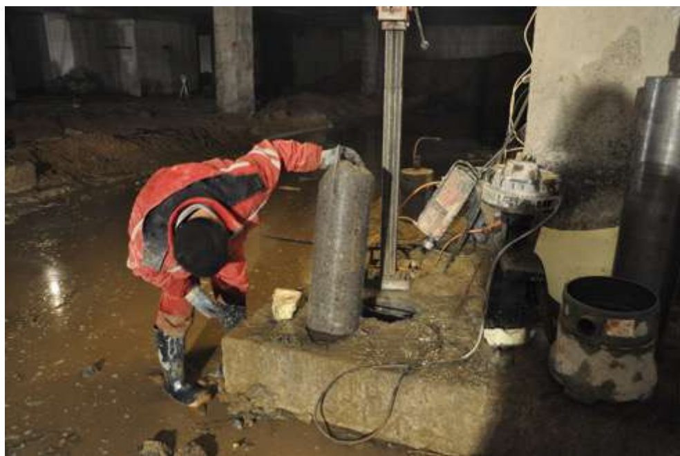
Рис.6.34. Проходка технологического отверстия
