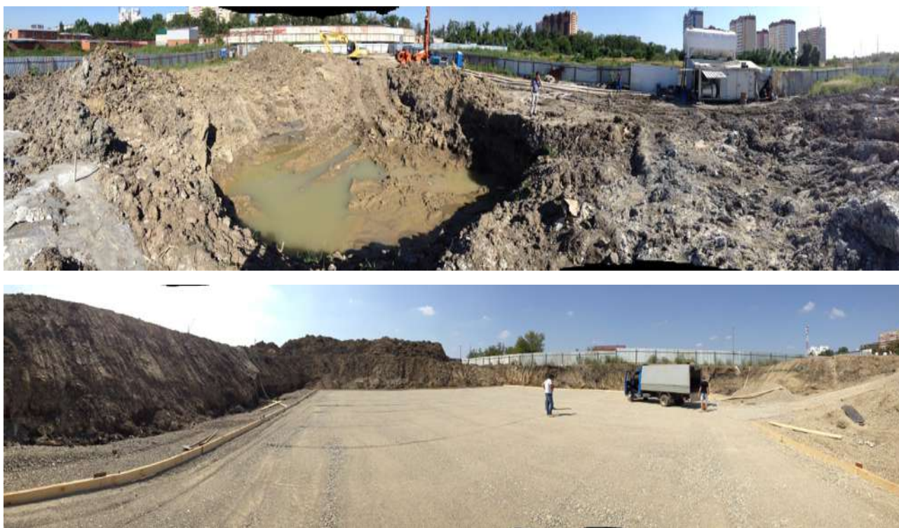
Рис.2.2. Общий вид площадки строительства до и после выполнения работ по устройству основания – «структурный геомассив»
