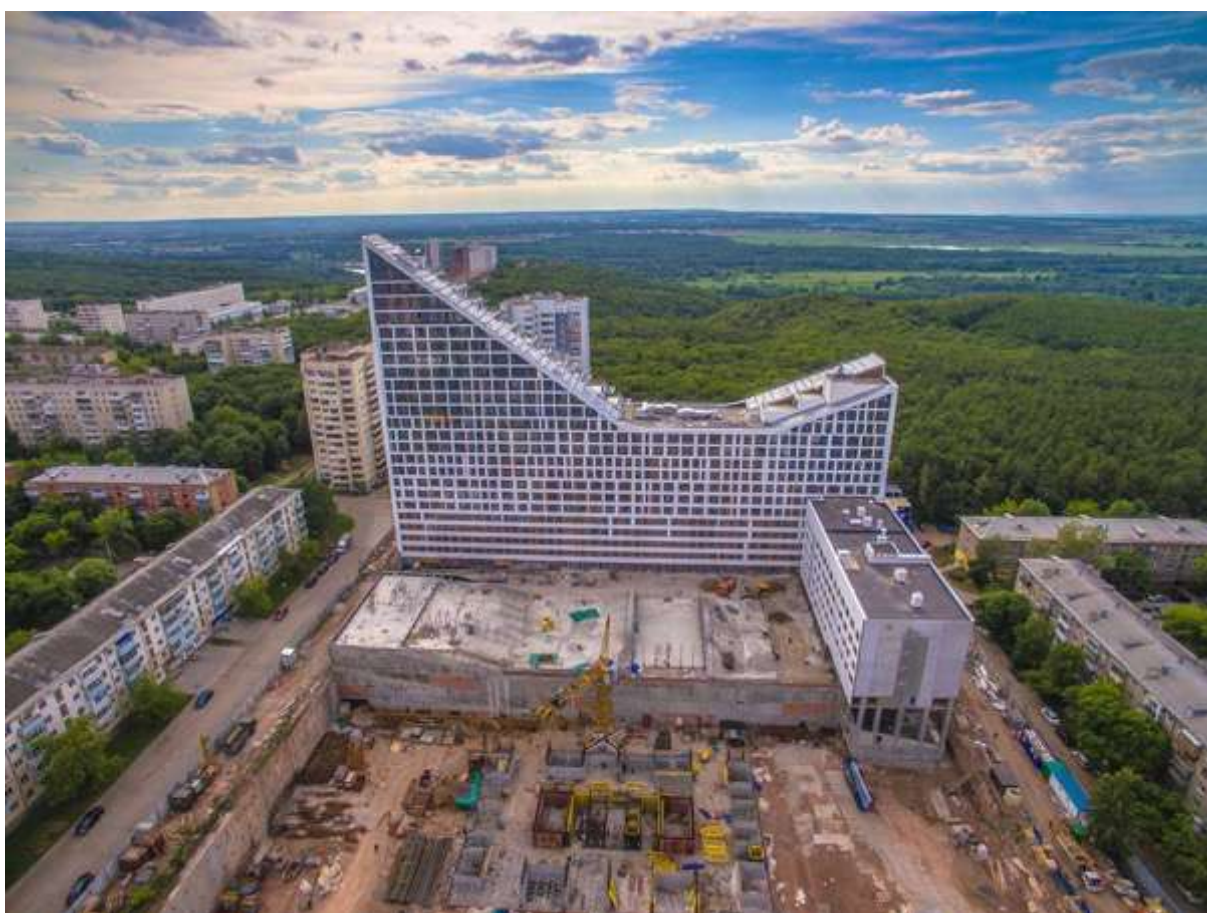
Рис. 6.19. Возведение подземной части комплекса
