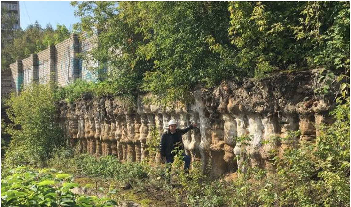
Рис.2.5. Вертикальный экран из грунтобетонных элементов
