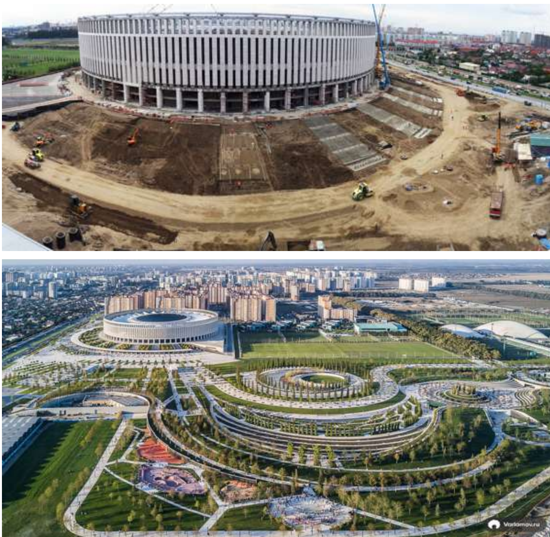
Рис.6.8. Этапы строительства комплекса зданий стадиона ФК «Краснодар»
